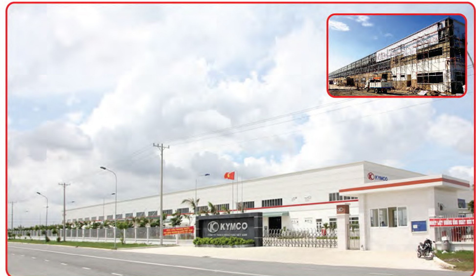
Nhà máy Kymco Kwang Yang KCN Đại Đăng/ Kymco Kwang Yang Factory
