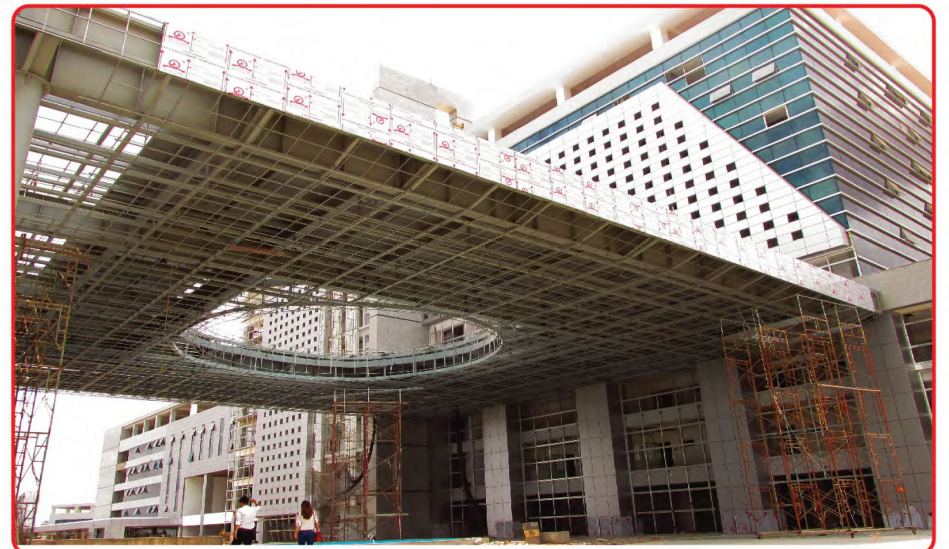
Bệnh viện đa khoa tỉnh Sóc Trăng/ Hospital Soc Trang Province
